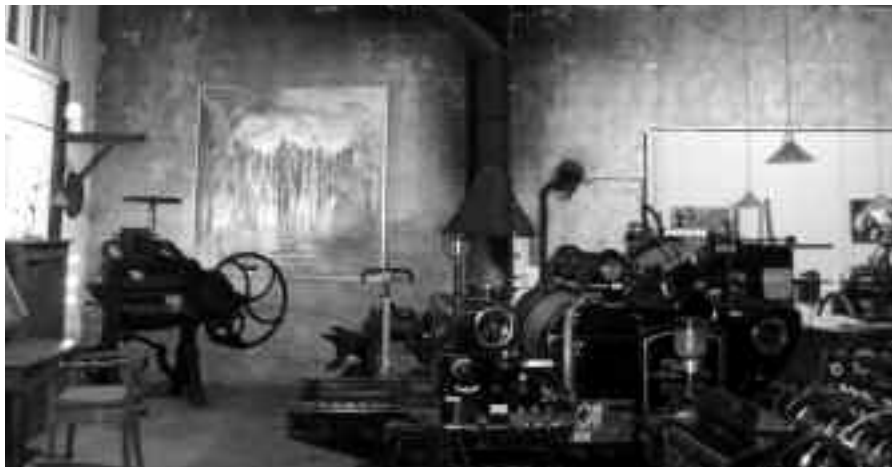
La salle des machines.
